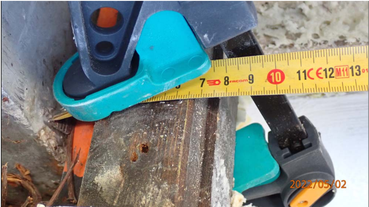
9 De breedte van de woning is nagemeten en vastgesteld op 4520 mm. Daar kunnen wel verschillen inzitten tussen de verschillende woningen omdat dit alles in het werk gestort beton is.
